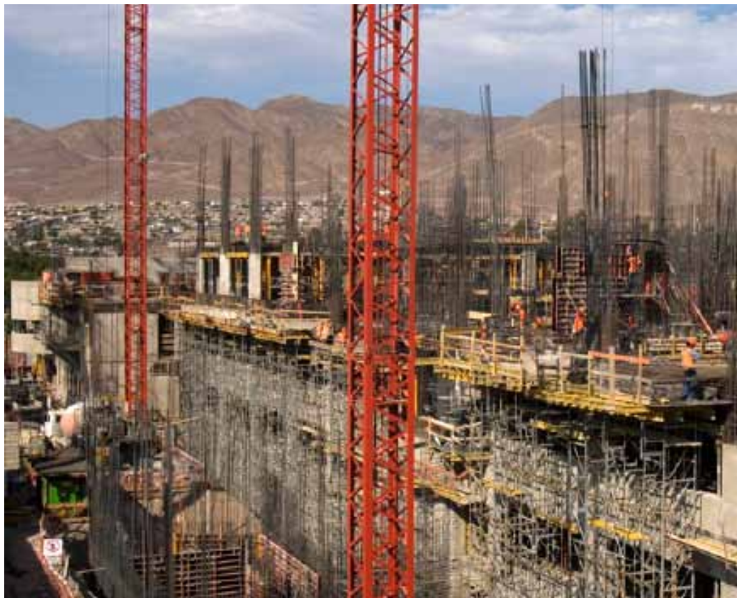
Hospital de Copiapó, Tercera Región.
