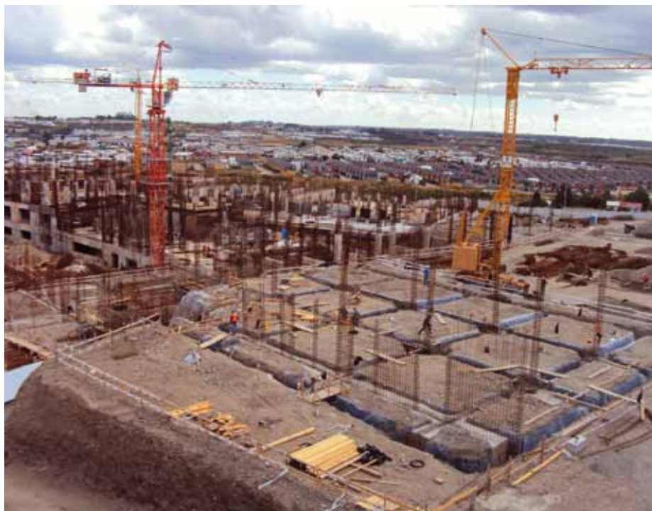
Hospital de Puerto Montt, Décima Región.
