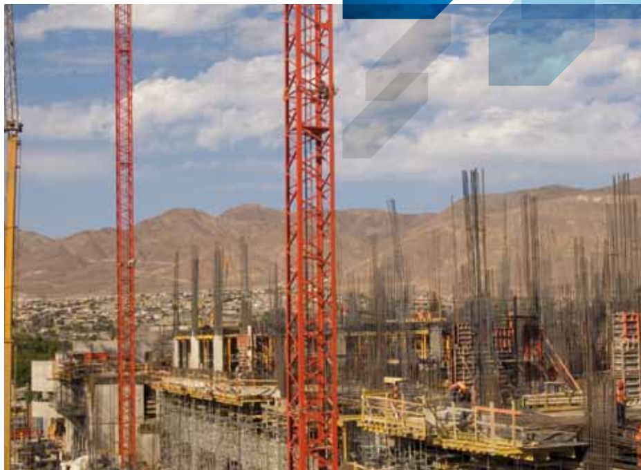
Hospital de Copiapó, Tercera Región.
