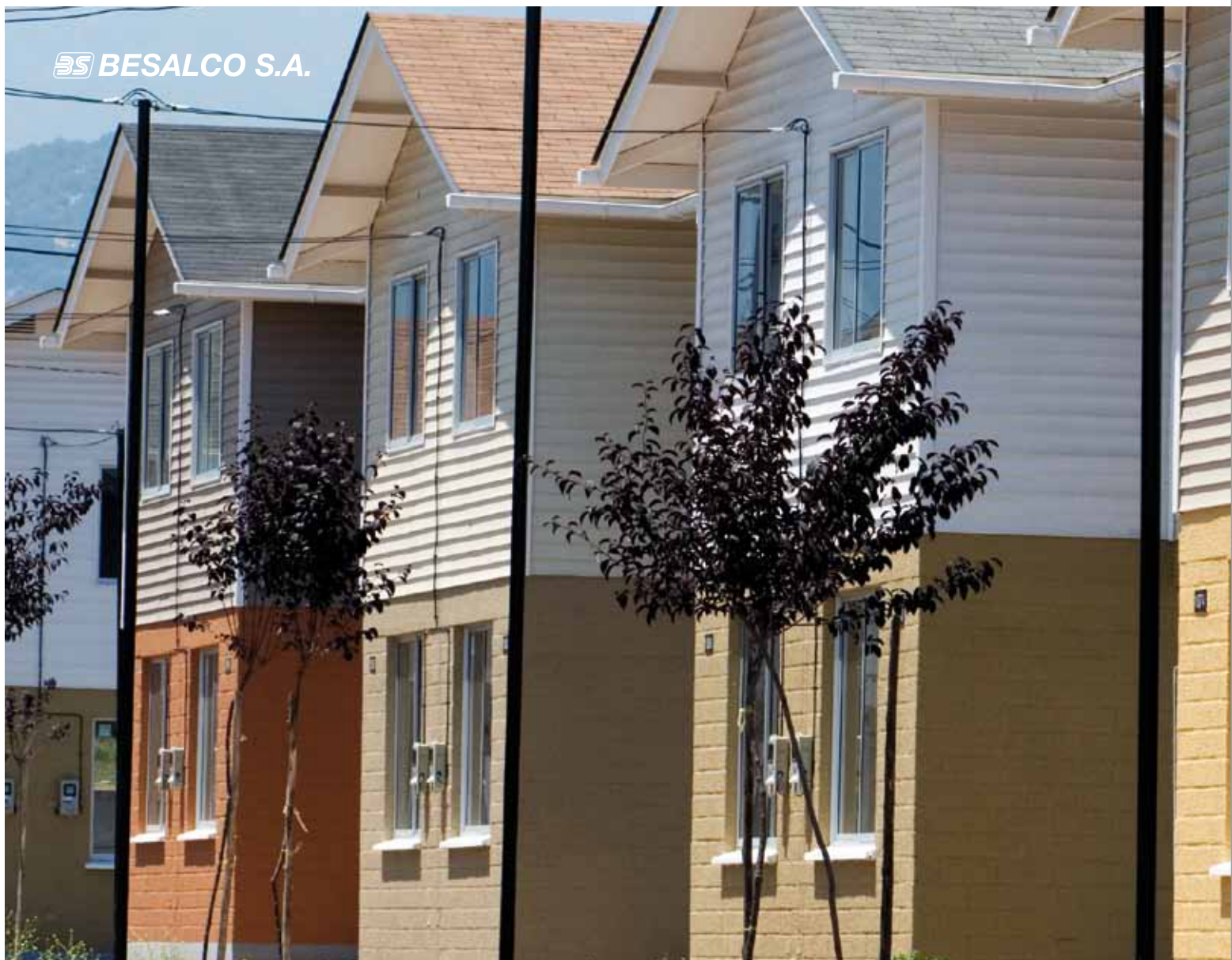
Proyecto La Ballena, Puente Alto, Región Metropolitana .
