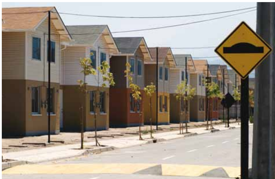
Proyecto La Ballena, Puente Alto, Región Metropolitana.
