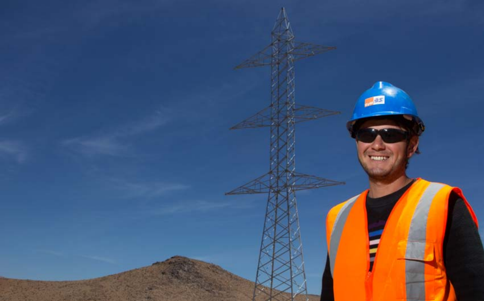
Líneas alta tensión Caserones
